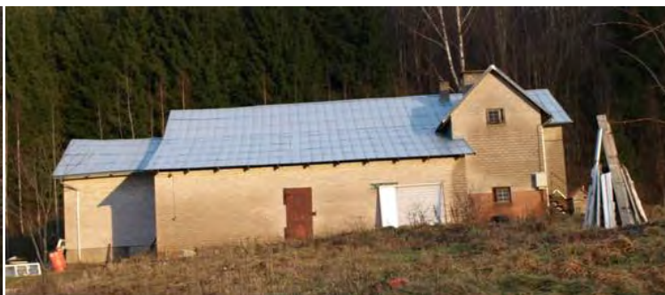
Žvelsenai. Sovietinė ūkinė destruktinė architektūra.
