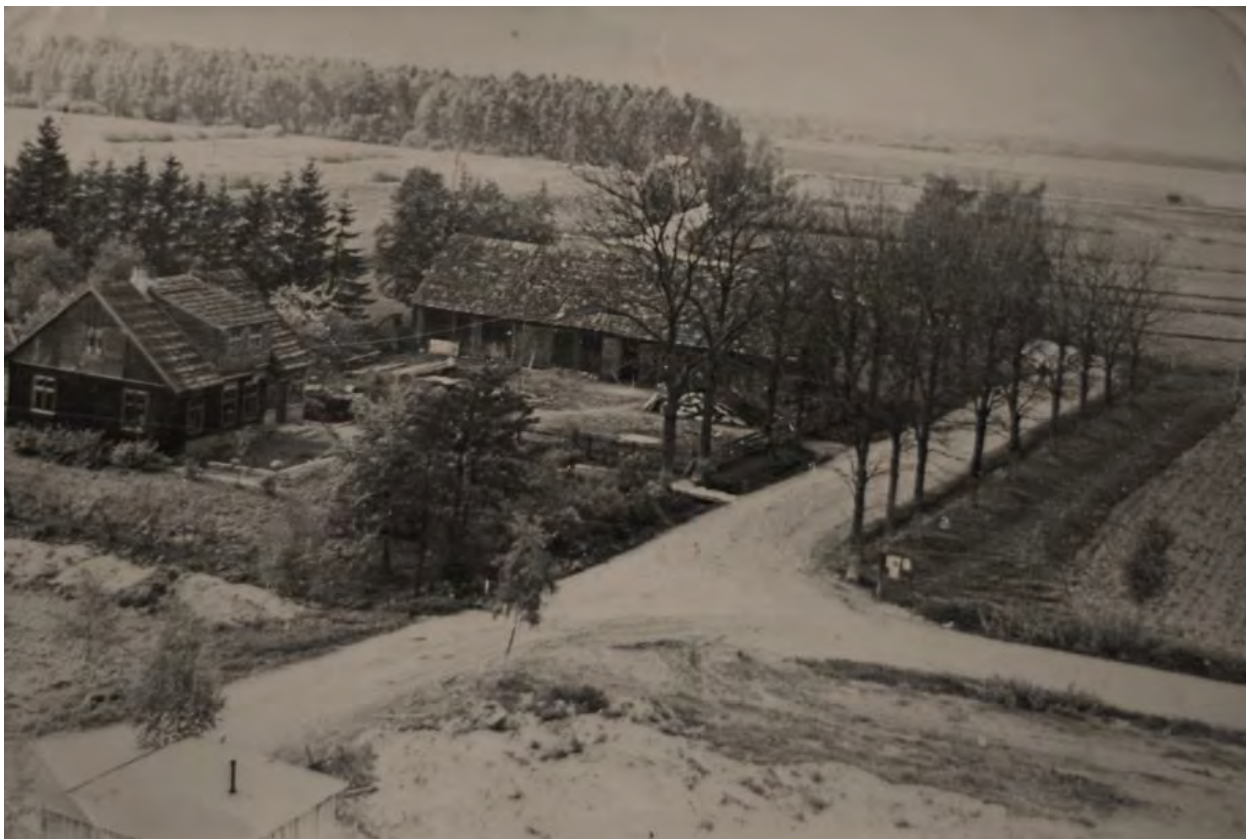
Būdingas Lapių apylinkių architektūrinis ansamblis.
